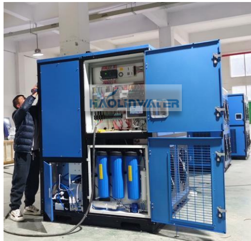
Taller de instalación
