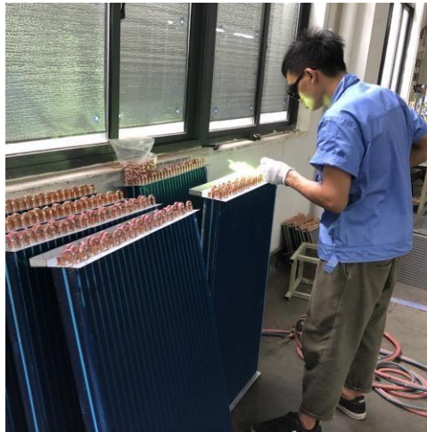
Soldadura de tubos
