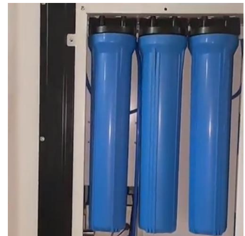
Instalacion de filtros
